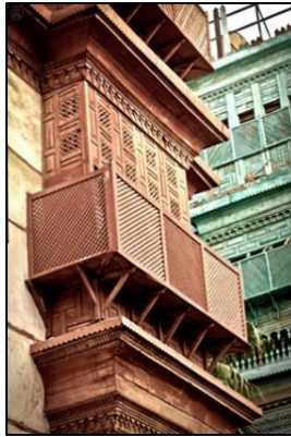
(شكل-6) رواشين قديمة في مبنى بجدة
